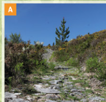
ANTIGA CALÇADA Calçada composta por lajes de granito, assentes de forma rudimentar, cuja construção se perde no tempo.
